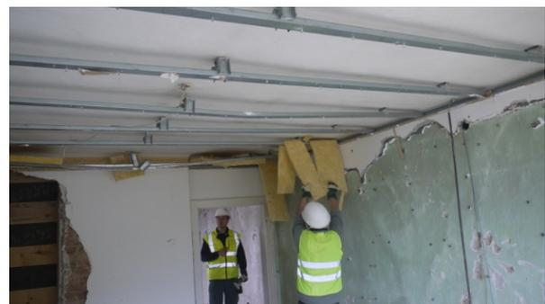
Abbildung 15: Entkernung – Ausbau Decken
