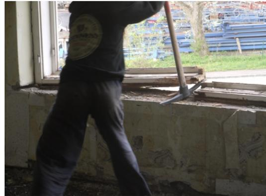
Abbildung 16: Entkernung – Ausbau Fensterrahmen händisch (Bild: TU Wien)
