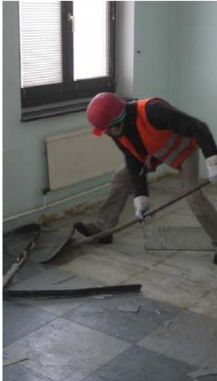
Abbildung 17: Entkernung – Ausbau Bodenbeläge (Bild: RMA)
