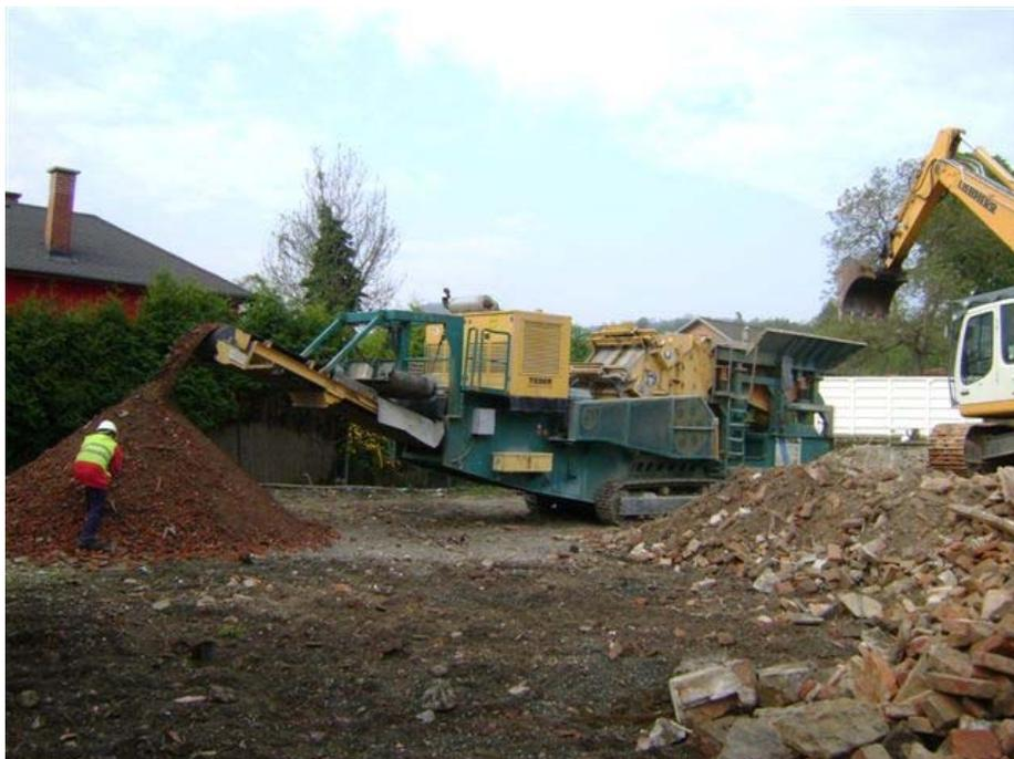
Abbildung 22: mobile Aufbereitungsanlage in Betrieb (Bild: TU Wien)
