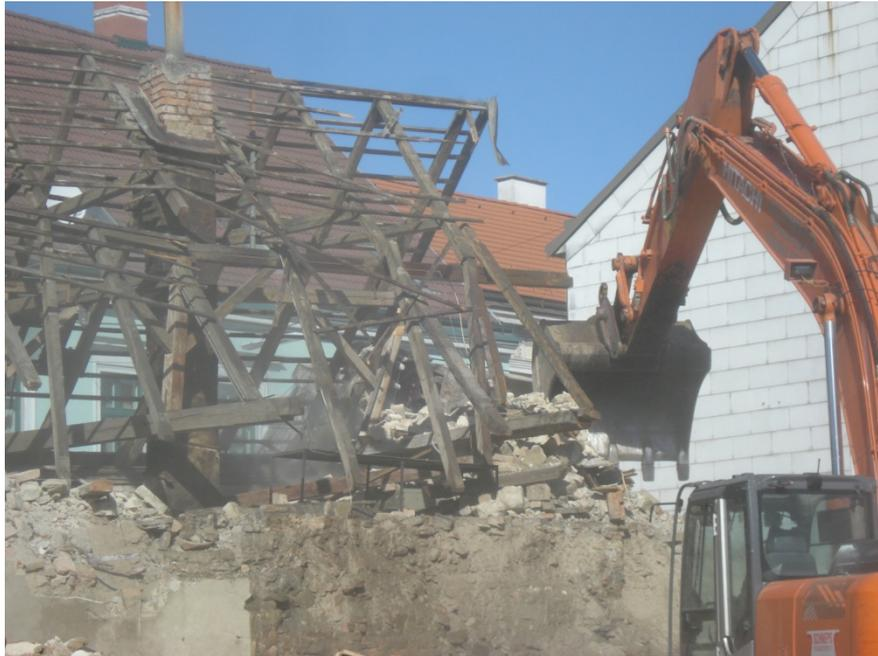
Abbildung 9: Einreißen bei Demolierung (Bild: RMA)
