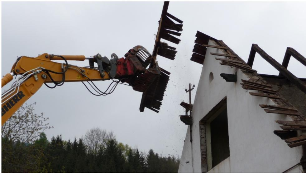
Abbildung 20: Selektiver Abbruch: Abgreifen des Dachstuhls (Bild: RMA)
