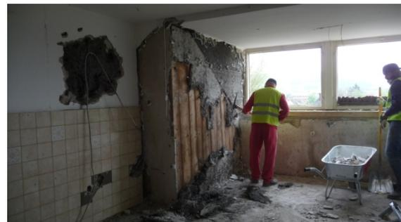
Abbildung 19: Entkernung – Ausbau Heraklitplatten (Bild: TU Wien)
