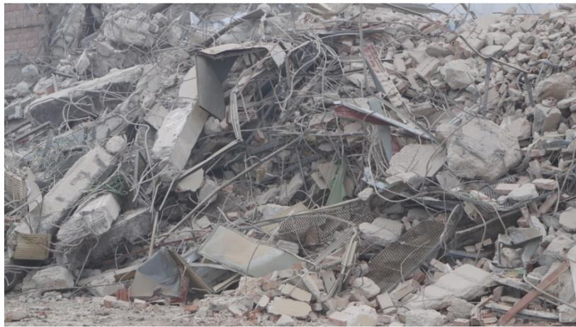
Abbildung 13: Bauschutt aus einer Demolierung mit vorhergehender Entkernung (Bild: RMA)
