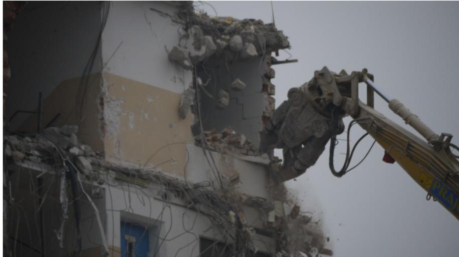
Abbildung 11: Abgreifen mit hydraulischer Zange bei Demolierung (Bild: RMA)
