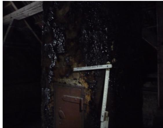
Abbildung 7: Schadstofferkundung: Bitumenhaltige Dichtbahn unter Badfliesen
