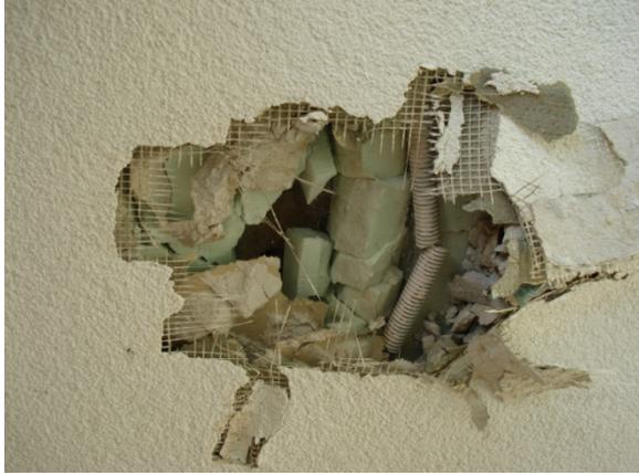
Abbildung 5: Erkundung Aufbau Decken
